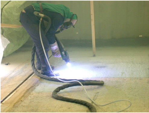
Bild 3: Thermisches Spritzverzinken von Beton – händisches Spritzen und Ansicht der verzinkten/unverzinkten Betonoberfläche (Abbildungen: Grillo Werke AG)
