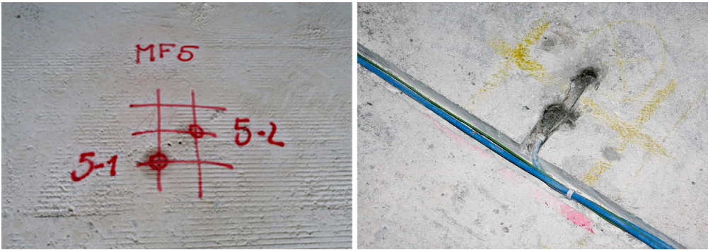
Bild 11: Markierungen der Stablagen und der Montagepositionen für die fest einzubauenden Referenzelektroden eines Monitoringfelds und Beispiel für eingemörtelte Referenzelektrode ERE20 und Kabelführung in gefrästem Kanal
