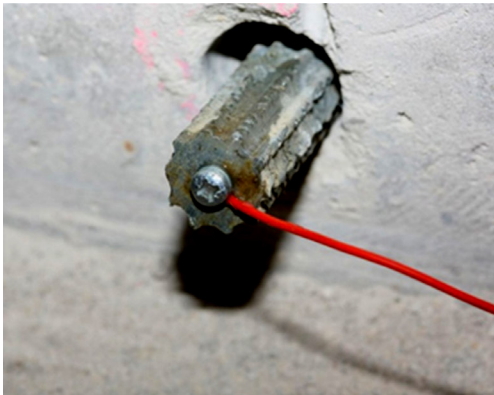
Bild 4: Beispiele für eine Zink-Stabanode (noch mit Spezialmörtel einzubauen) und für Zink-Hydrogelfolie
