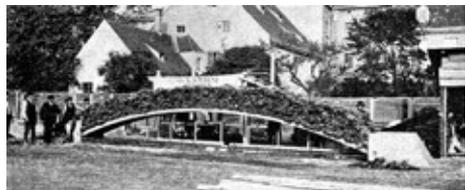
*Bild 1: Belastungsprobe eines Monierbogens durch Bauschinger, München, 1887*
