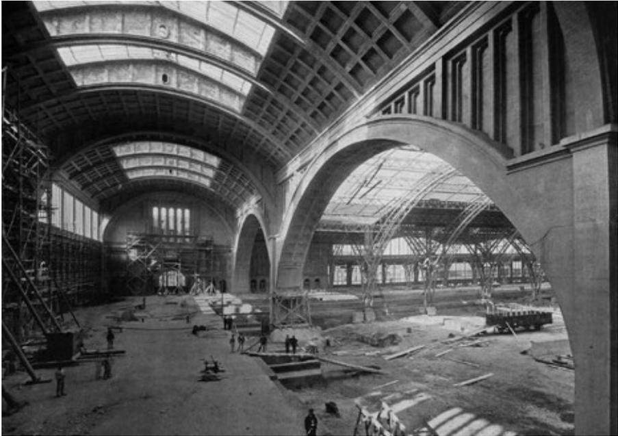
*Bild 5: Innenansicht der Konstruktion der Querbahnsteighalle des Hauptbahnhofes Leipzig
