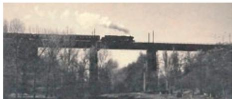
Bild 8: Bauwerk von 1936 mit Vollwandträgern unter Betrieb Foto: [6]
