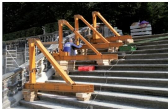
Bild 4: Aufbau der Belastungsrahmen auf der westlichen Treppe Foto: Sabine Wellner
