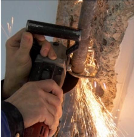
*Bild 10: Entnahme eines Bewehrungsseisens eines Unterzugs über dem Erdgeschoss im Beyer-Bau*
